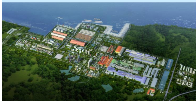
宝钢湛江钢铁精品基地项目
